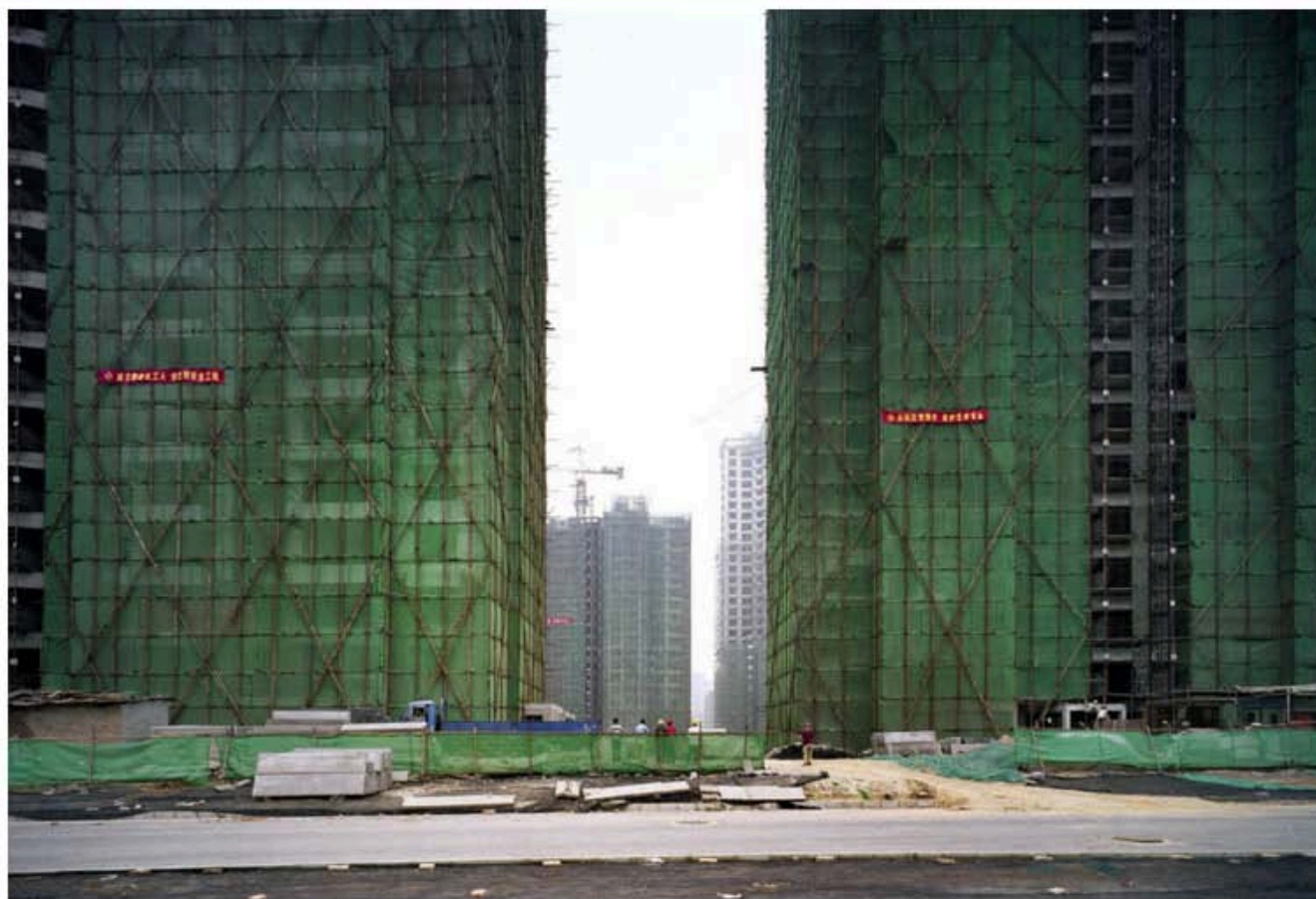
Pékin, chantier de constructions de futurs logements collectifs en mai 2007 ©
