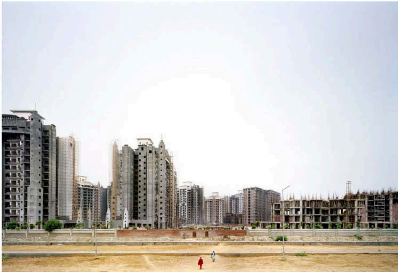
Ville nouvelle de Greater Noida en grande banlieue de New Dehli, chantier de groupe d'immeubles © Patrick Tourneboeuf
