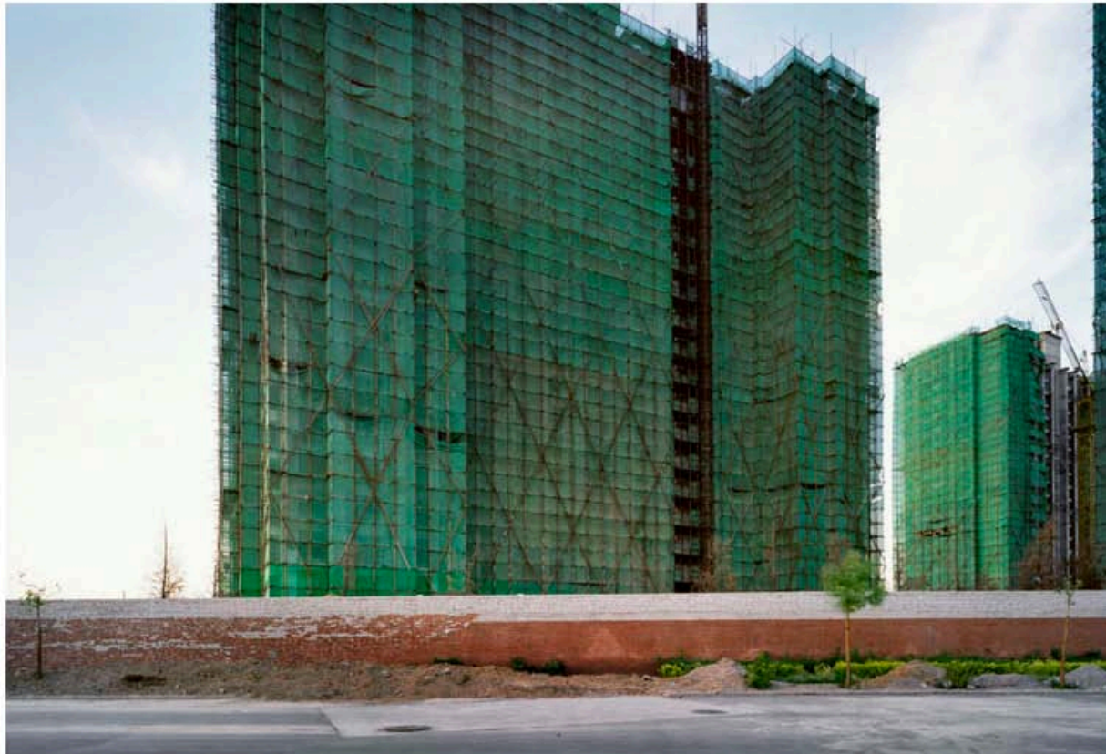
Pékin, chantier de constructions de futur logements collectifs et d'une station de métro © Patrick Tourneboeuf
